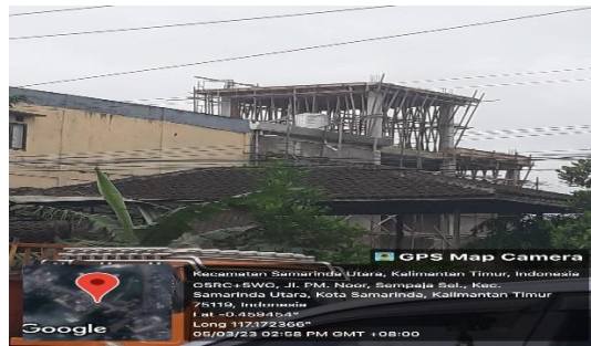
Gambar 14. Konstruksi Bangunan di Kelurahan Sempaja Selatan, Kecamatan Samarinda Utara
