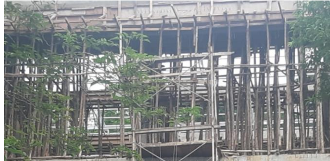
Gambar 10. Konstruksi Bangunan di Kelurahan Temindung Permai, Kecamatan Sungai Pinang
