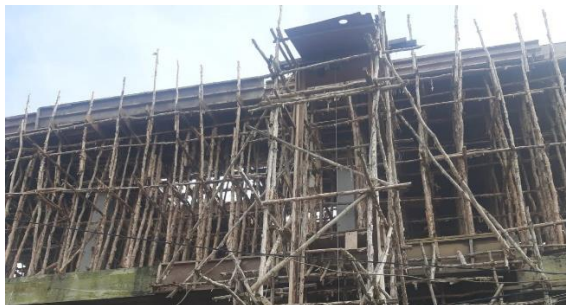
Gambar 5. Kontruksi bangunan di Kelurahan Loa Bakung, Kecamatan Sungai Kunjang
