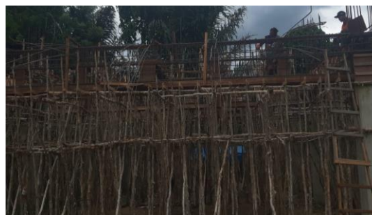
Gambar 3. Kontruksi bangunan di Kelurahan Gunung Kelua, Kecamatan Samarinda Ulu
