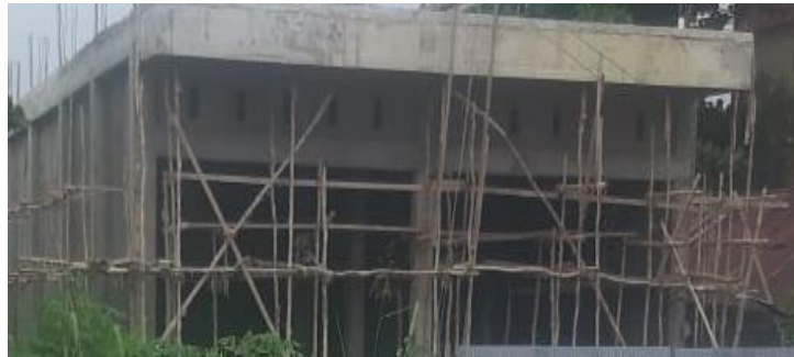
Gambar 13. Konstruksi Bangunan di Kelurahan Sempaja Utara, Kecamatan Samarinda Utara
