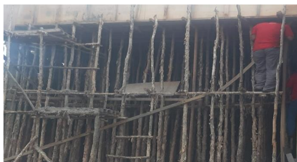
Gambar 12. Konstruksi Bangunan di Kelurahan Sempaja Selatan, Kecamatan Samarinda Utara
