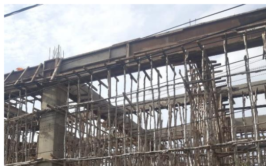
Gambar 4. Kontruksi bangunan di Kelurahan Lok Bahu, Kecamatan Sungai Kunjang
