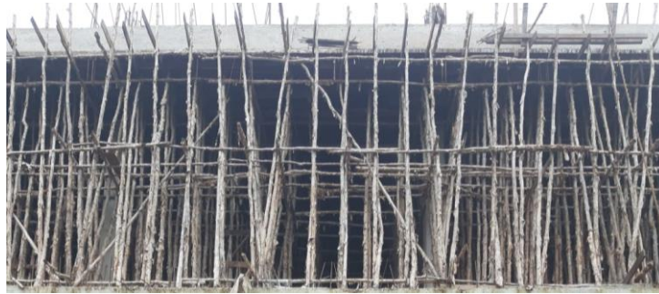
Gambar 7. Kontruksi Bangunan di Kelurahan Sempaja Selatan, Kecamatan Samarinda Utara
