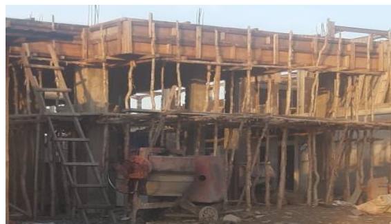
Gambar 15. Konstruksi Bangunan di Kelurahan Sempaja Selatan, Kecamatan Samarinda Utara
