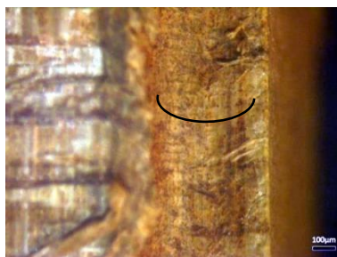
Gambar 26. Kerusakan akibat pemakuan menggunakan paku kayu
